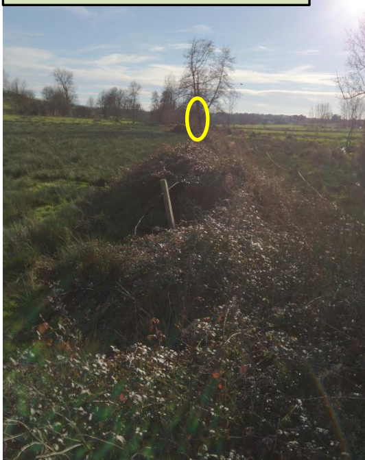
Avant travaux décembre 2013
