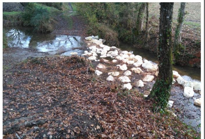
Après travaux Avril 2016, rechargement aval du gué pour diminuer les pentes et diversifier les écoulements
