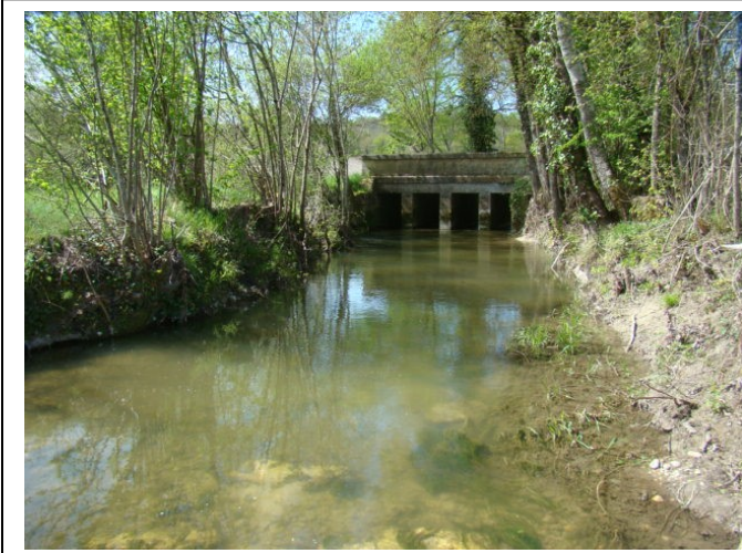
Après travaux : aval du pont : avril 2016
