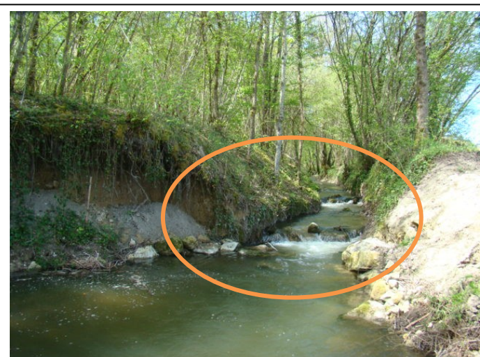
Après travaux vue de la chute depuis l'aval
