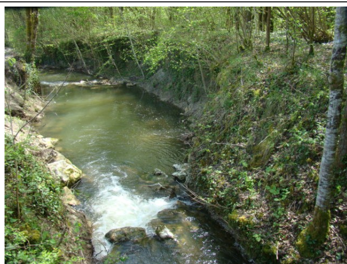
Après travaux vue de la chute depuis l'amont
