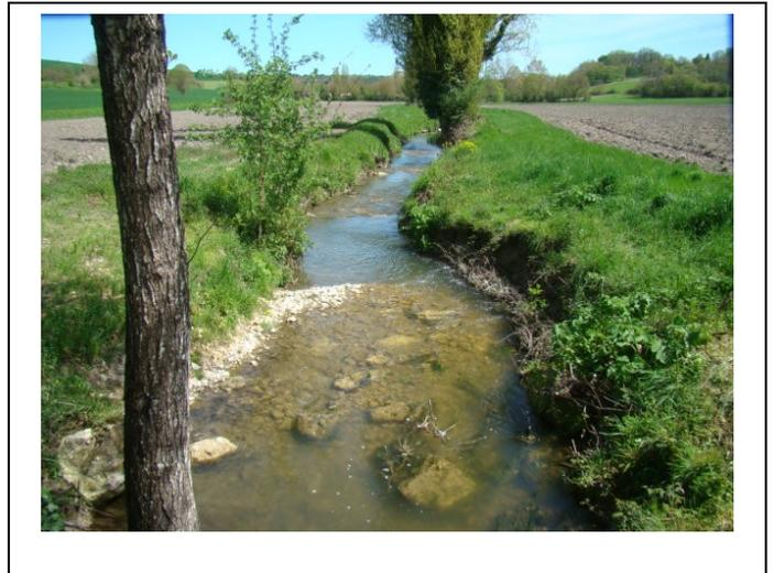
**Aval de la vanne : rechargement du lit mineur pour diminuer les pentes et diversifier les écoulements**
