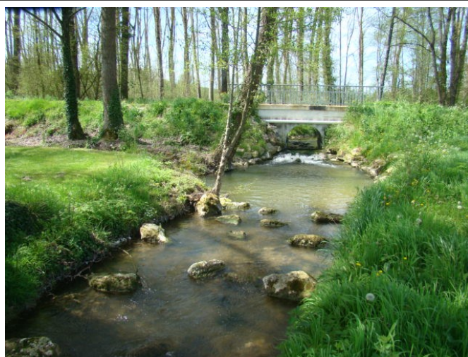
Aval du pont en avril 2016
