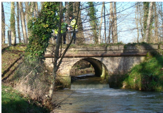
Avant les tout premiers travaux : Aval du pont en 2013
