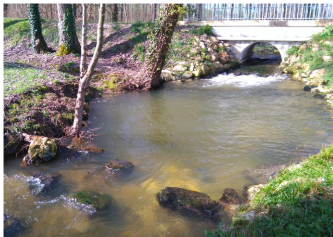
Après travaux : Aval du pont en janvier 2016
