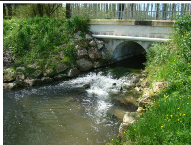
Après travaux : chute aval du pont en avril 2016
