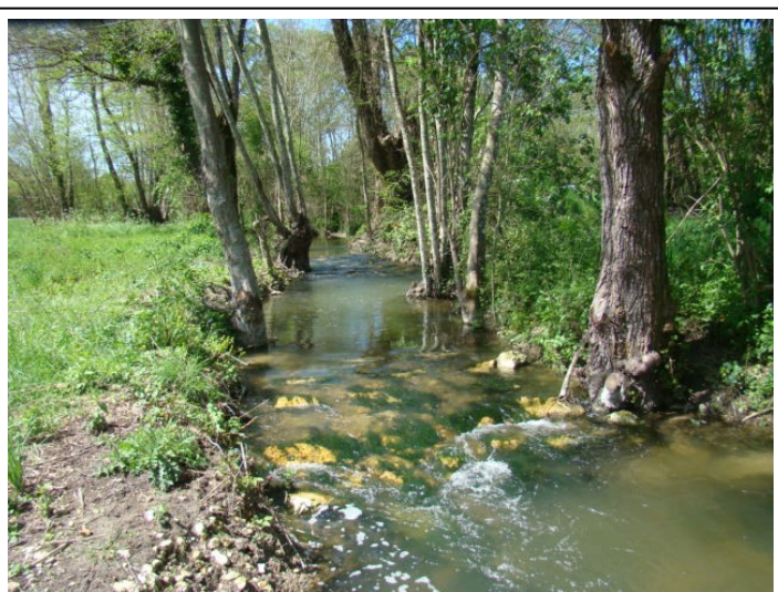
Après travaux : aval du gué, vu par l'aval
