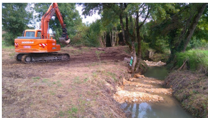
Pendant travaux Automne 2015
