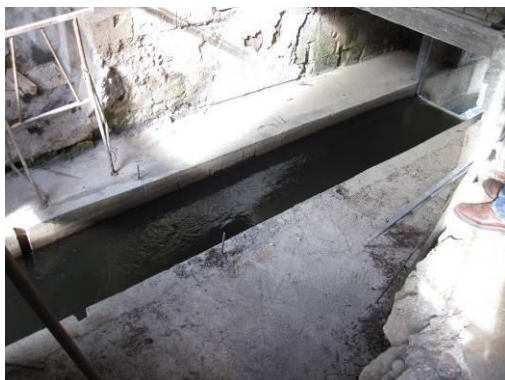
Canal de dévalaison (avant travaux)
