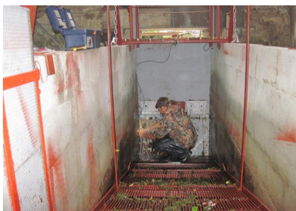
Fig. 32 : Installation de l'antenne RFID à Monfourat
