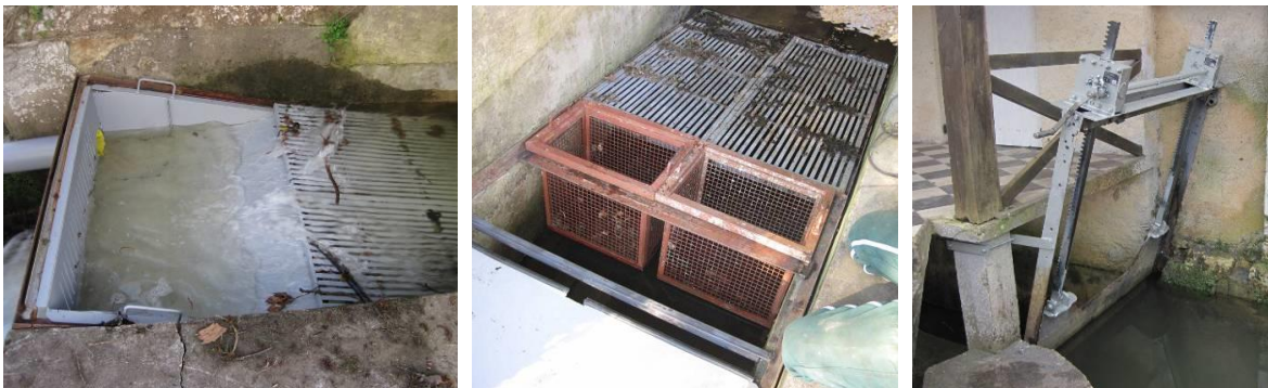
Fig. 21 : Renamon en configuration classique (g), avec paniers (c) et le vannage (d)
