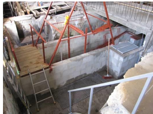
Canal avec pêcherie (après travaux)
