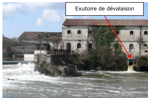
Usine vue de l'aval
