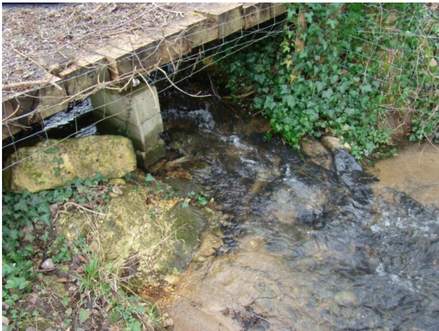
Après travaux : Aval du pont en basses eaux
