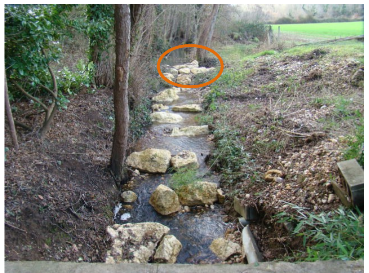
Après Travaux : Aval du seuil
