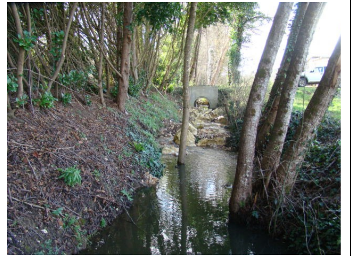
Après travaux : Aval du pont vu par l'aval
