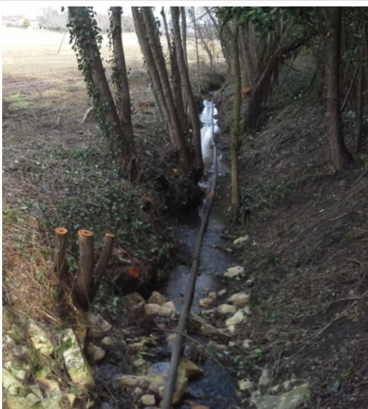
Avant Travaux aval Buse vue du pont
