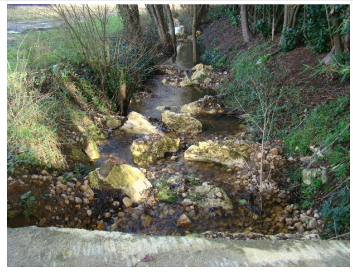
Après Travaux aval Buse vue du pont
