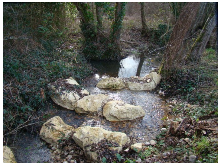
Après Travaux + zone humide et forêt alluviale préservées en amont
