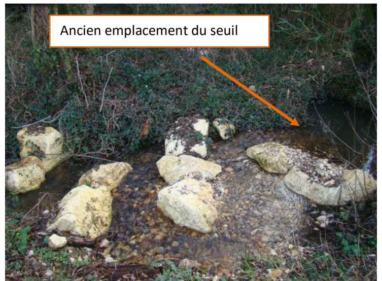
Avant Travaux : Seuil effacé vu rive gauche
