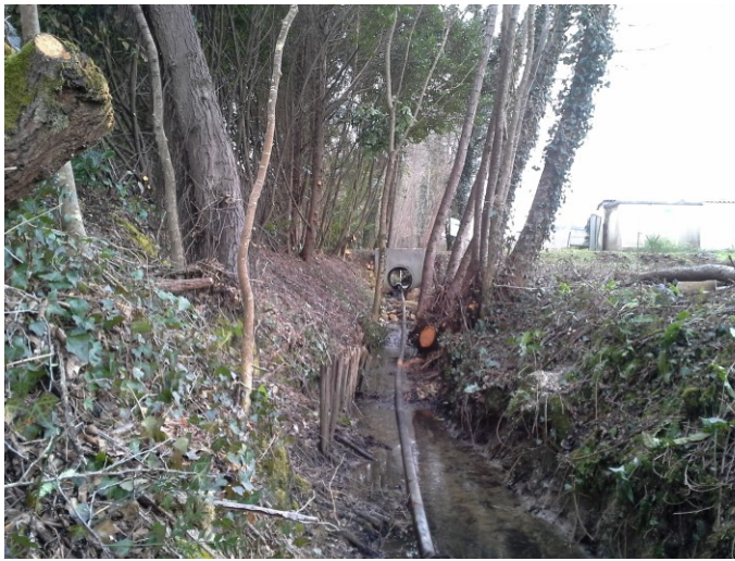
Avant travaux : Aval du pont vu par l'aval
