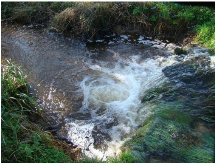
Avant Travaux : chute aval de la buse
