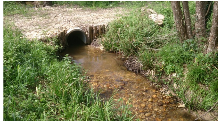
Après Travaux : Aval de la buse (vue par l'aval Juin 2015)
