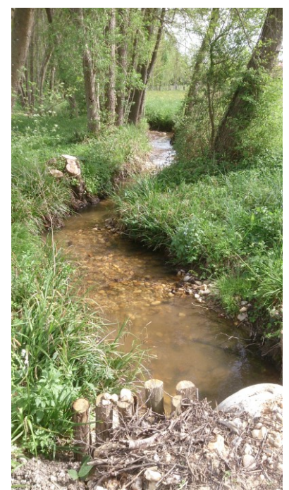
Après Travaux : Aménagement aval de la Buse
