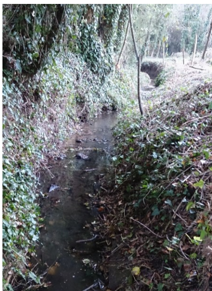
Avant Travaux : Aval de la buse vue
