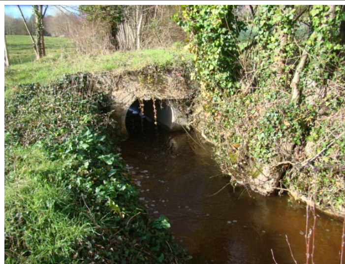
Après Travaux : Aval du Pont (vue par l'aval) Janvier 2016
