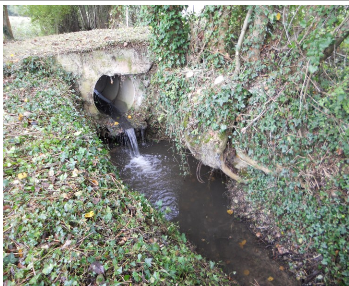
Avant Travaux : Aval du pont (vue par l'aval)
