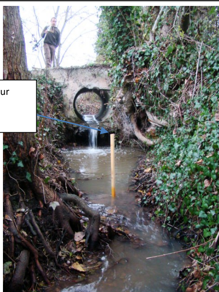
Avant Travaux : buse vue par l'aval
