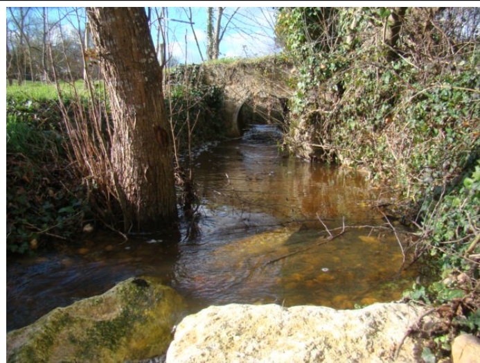
Après Travaux : buse vue par l'aval
