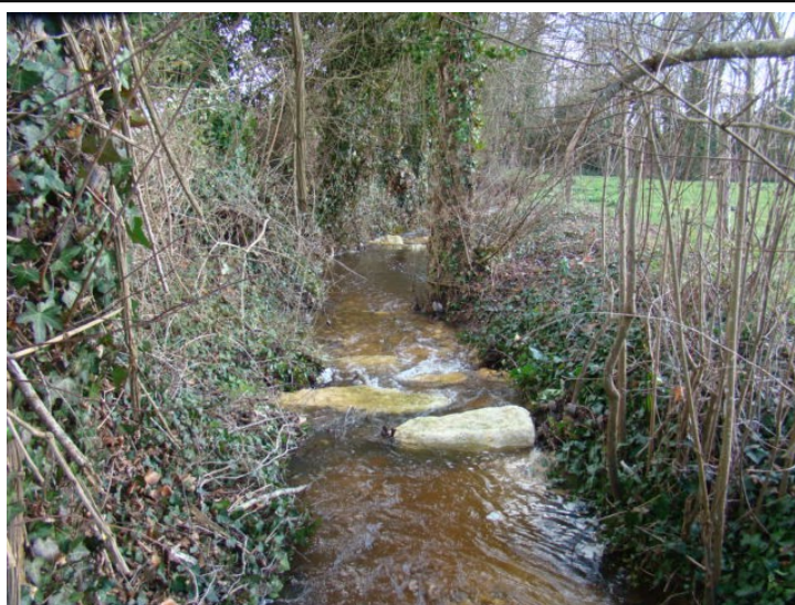
Après Travaux : Aménagement aval de la buse janvier 2016
