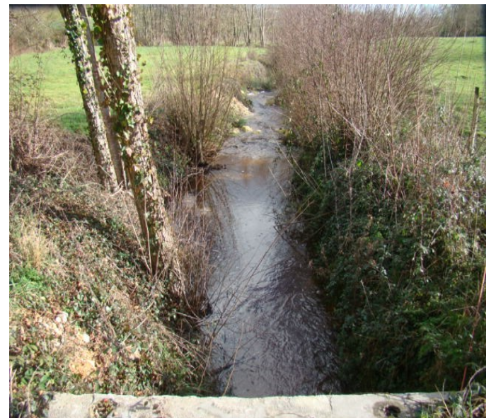
Avant Travaux : Aval buse vue par le haut (janvier 2016)
