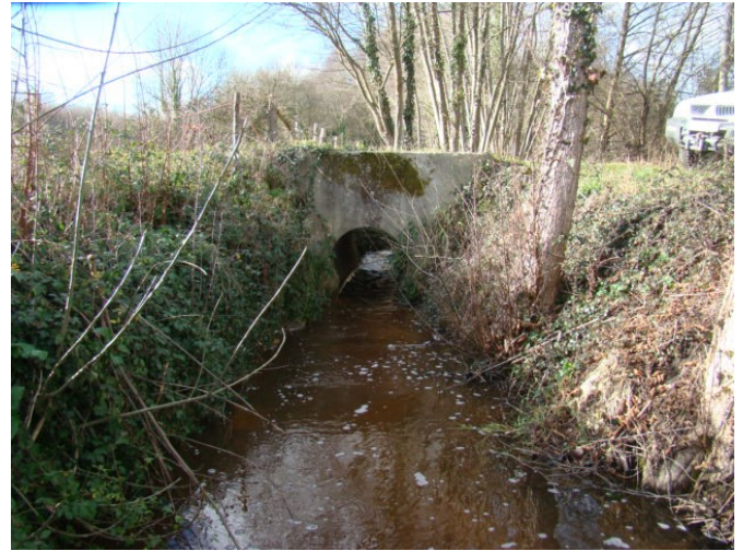
Après Travaux : Aval du pont ( janvier 2016)
