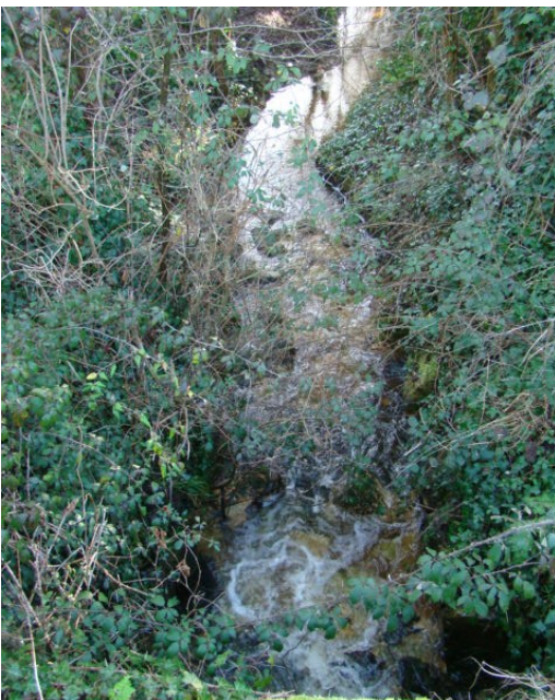
Avant Travaux : Aval buse vue par le haut
