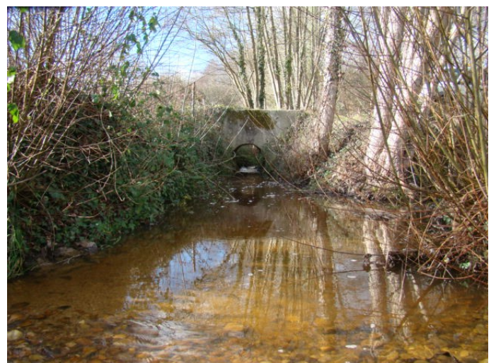
Après Travaux : Amont du pont (juin 2015)
