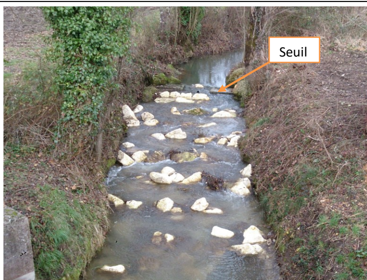
Après Travaux : Aval du seuil, vu par l'aval (janvier 2015)
