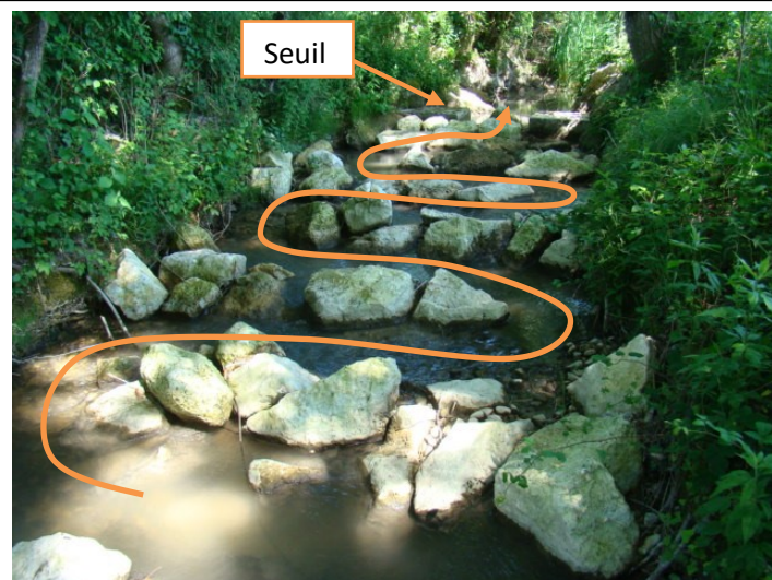
Après Travaux : Aval du seuil (juin 2015)
