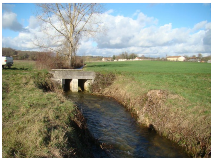
Après Travaux : Aval buse
