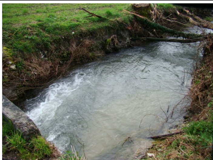
Avant Travaux : Amont du pont
