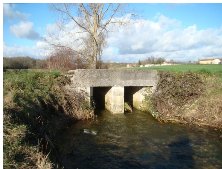
Après travaux vue par l'aval
