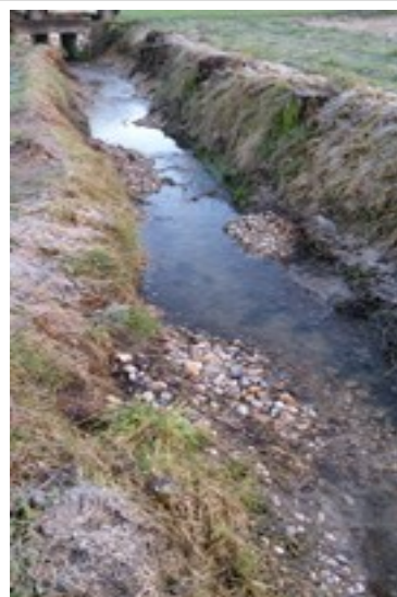
Pendant Travaux : Aval buse
