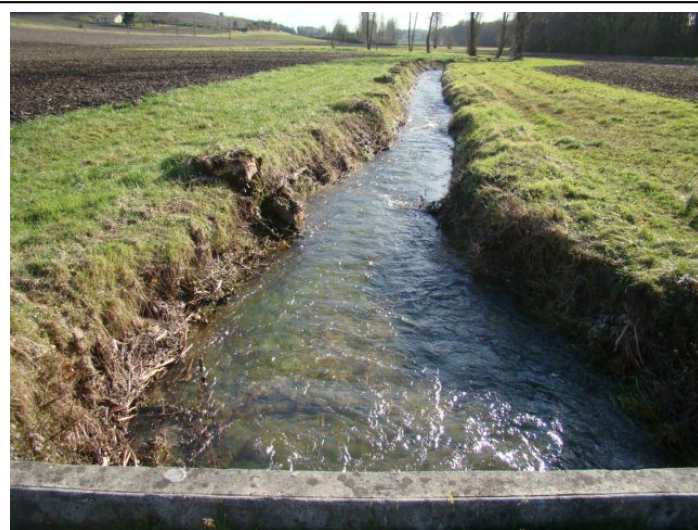
Après Travaux : Amont du pont
