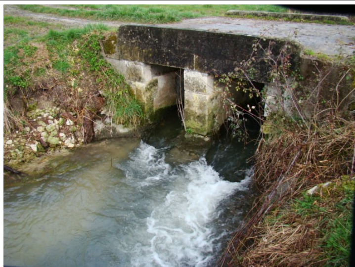
Avant Travaux : Aval du pont (vue par l'aval)
