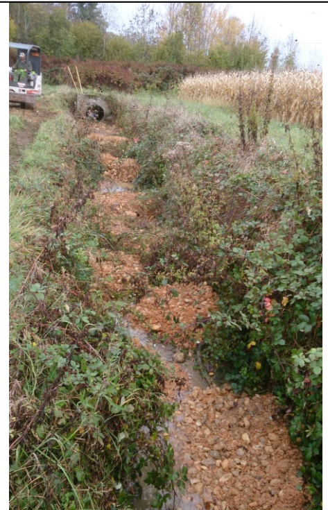
Buse 2 : Pendant Travaux : vue aval
