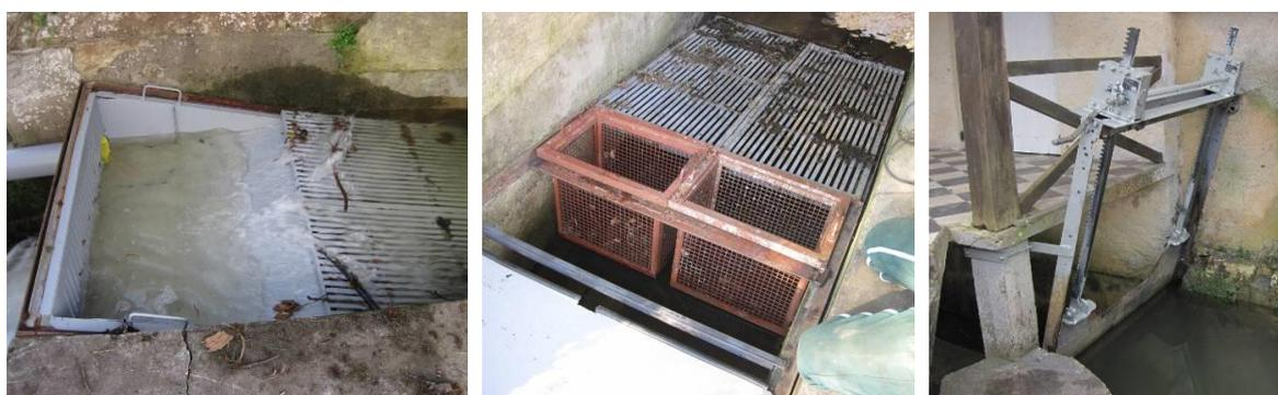
Fig. 21 : Renamon en configuration classique (g), avec paniers (c) et le vannage (d)
