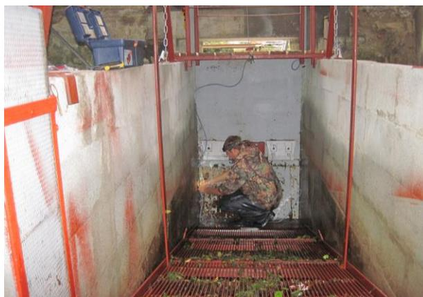
Fig. 32 : Installation de l'antenne RFID à Monfourat
