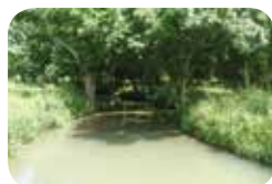
Canal de décharge (6)
