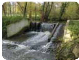
Passé à anguille sur le Lary au niveau du déversoir du moulin Berland à Montlieu-La-Garde.
