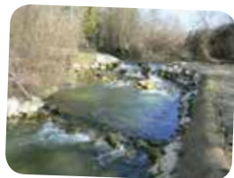
Passé à poisson sur le Trèfle au niveau du déversoir du moulin de l'Ancrevier à Saint-Ciers-Champagne.
