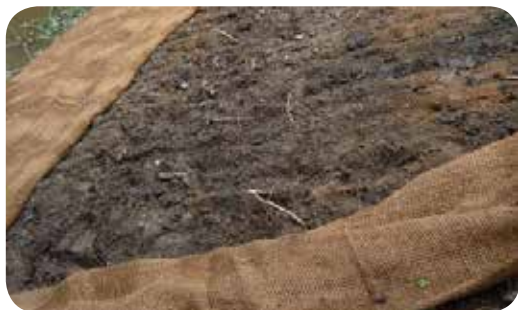
Pendant les travaux
