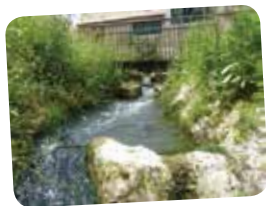
Passé à poisson au niveau des vannes de décharge au moulin de Guiffier à Jonzac.
