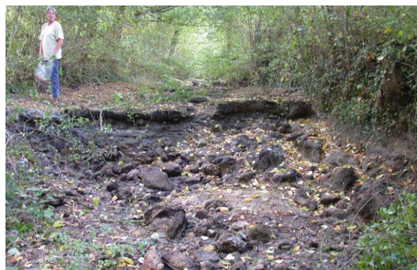
Avant Travaux : 1e zone d'incision photo prise par l'aval en septembre 2005
