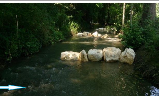
Après travaux vue par l'aval 150 m en dessous du point d'incision. Blocs posés dans le but de diminuer la pente et de ralentir les vitesses d'écoulements
