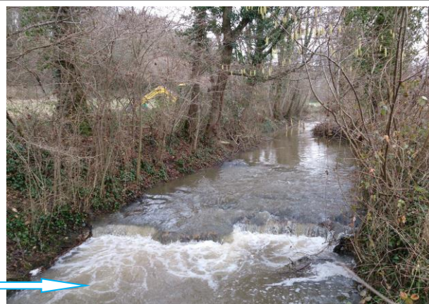
Avant Travaux : 1e zone d'incision prise en rive gauche par l'aval avec création de risbermes en amont
