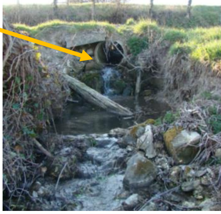
Avant travaux chute aval de la buse
