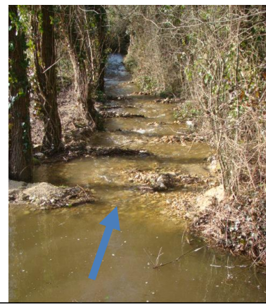
Après travaux vue sur l'aval du pont
