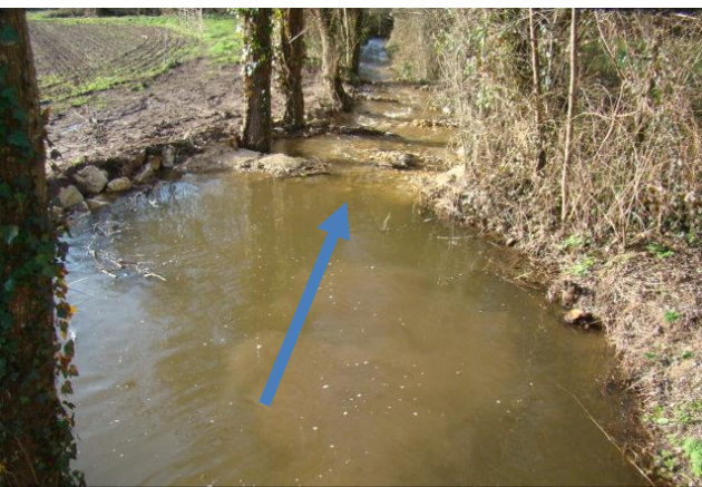
Après travaux vue sur l'aval du pont
