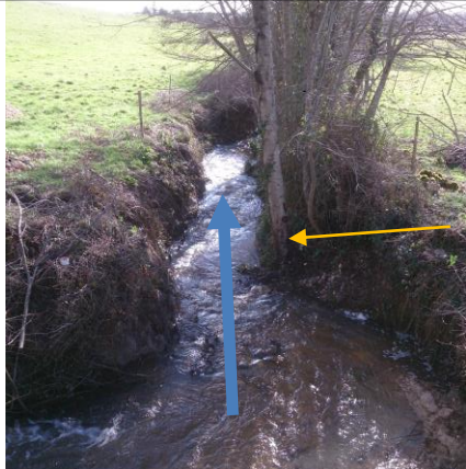
Avant travaux vue aval pont
