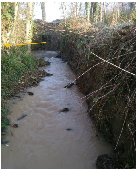
Avant travaux vue aval pont
