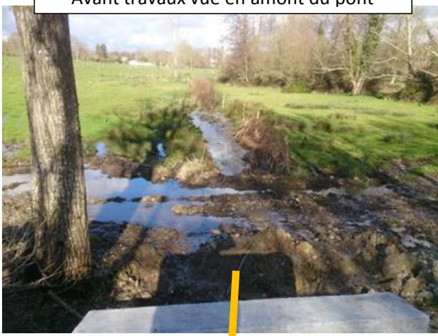
Avant travaux vue en amont du pont
