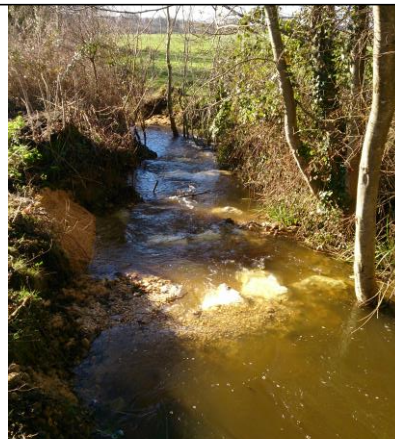
Après les travaux vue 50 m en aval du pont
