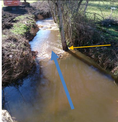
Durant les travaux vue aval du pont
