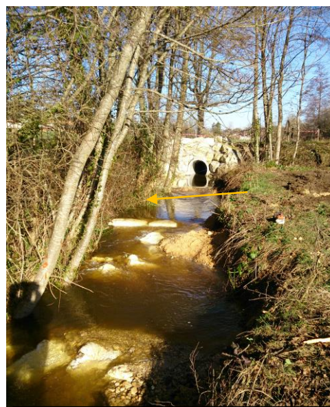
Après travaux vue aval pont
