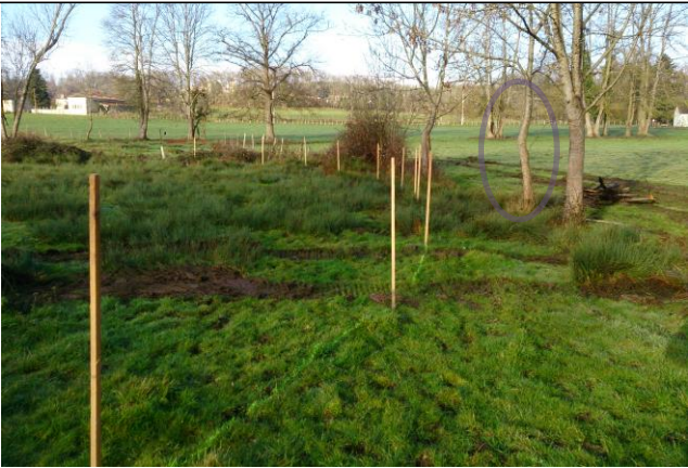
Implantation du tracé du nouveau cours d'eau
