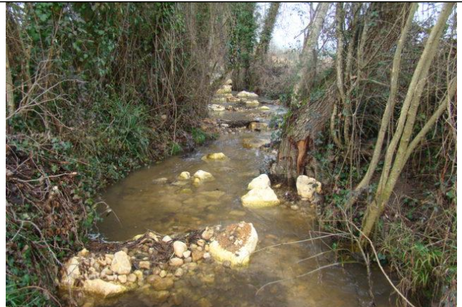
Rechargements en aval du pont
