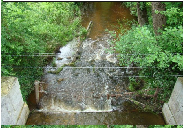
Avant travaux : photo prise depuis le pont vers l'aval
