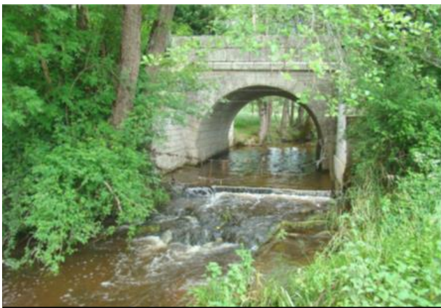
Avant travaux vue par l'aval du pont
