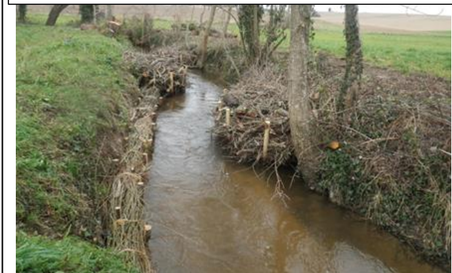
Aménagement génie végétal et de risbermes en aval ouvrage
