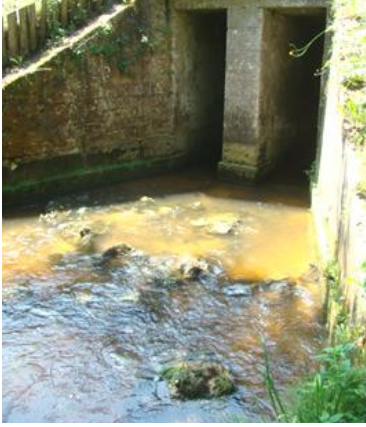
Avant travaux aval pont
