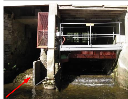
Fig. 24 : Muret de protection du vivier
