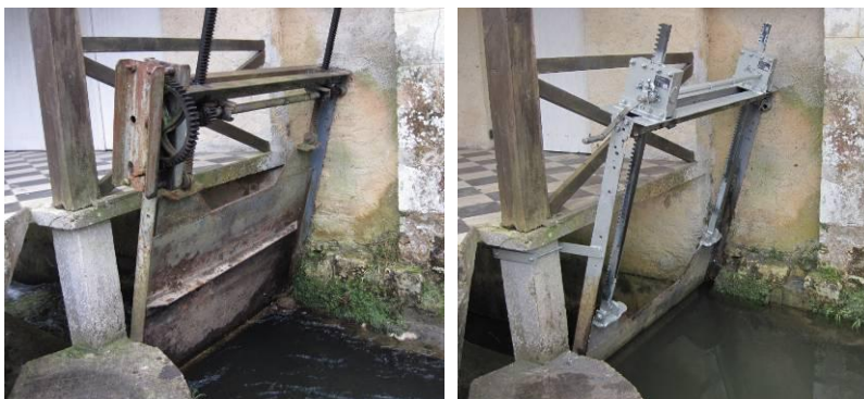
Fig. 21 : Ancien (g.) et nouveau (d.) vannage
