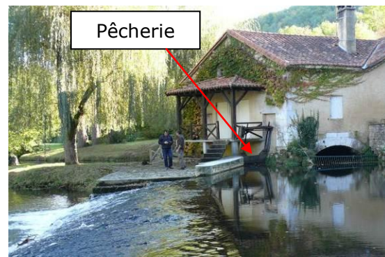
Moulin vu depuis l'amont
