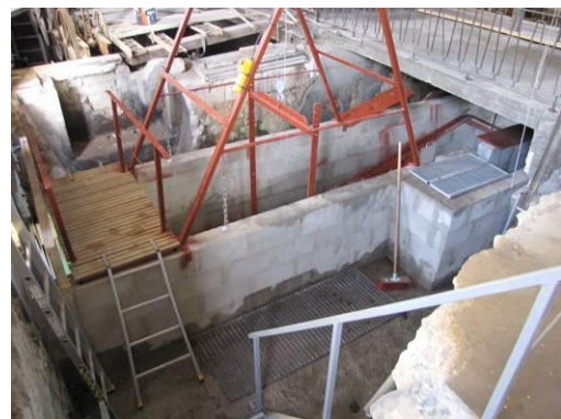
Canal avec pêcherie (après travaux)
