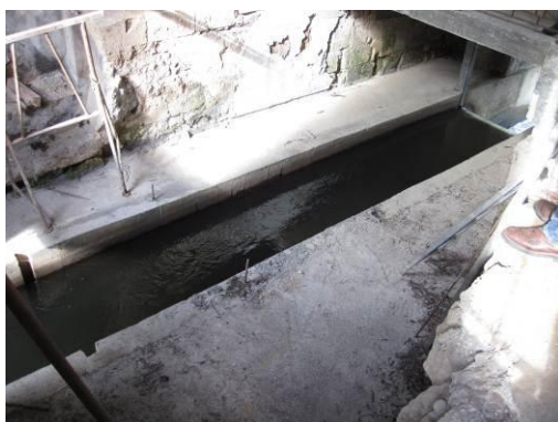
Canal de dévalaison (avant travaux)
