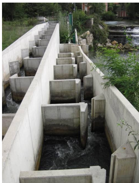
Fig. 3 : Passe à bassin (premier plan) et rampe à brosse (second plan) de Monfourat
