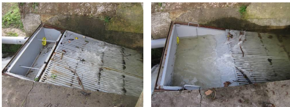
Fig. 22 : Goulotte avant (g.) et après (d.) modification
