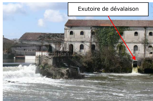
Usine vue de l'aval
