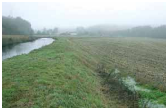
▲ Ph. 134 - Section artificielle du Rouloir en position perchée avec labours en contrebas. La remise du cours d'eau en fond de talweg ne sera pas facile.
