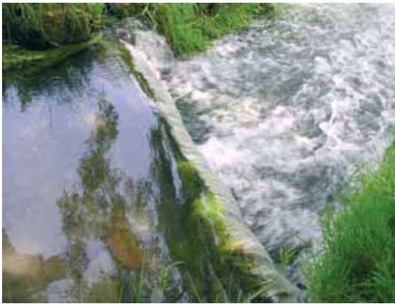
▲ Ph. 147 - L'écoulement rapide sur le radier au pied de ce petit barrage le rend tout à fait infranchissable.
