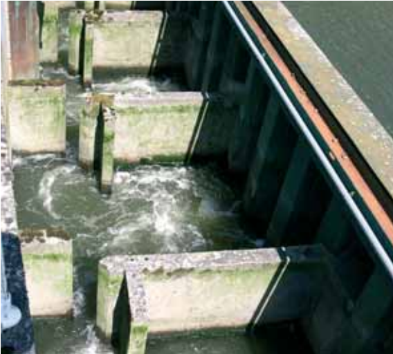
▲ Ph. 152 - Passe à bassins à fentes verticales à Poses sur la Seine.
