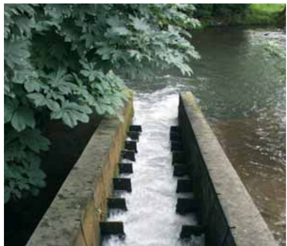
▲ Ph. 151 - Passe à ralentisseurs à Gamaches sur la Bresle.
