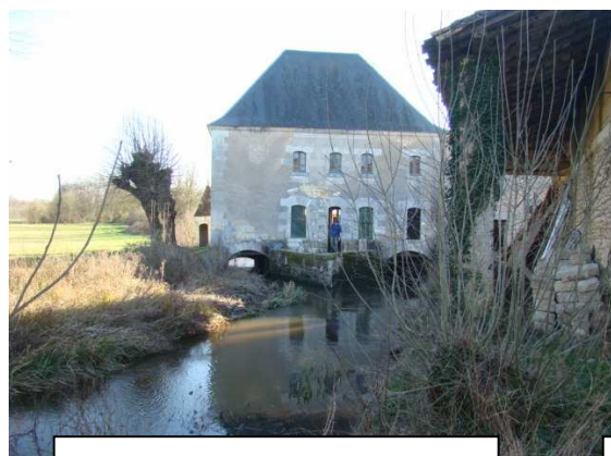
Amont du moulin de Roche
