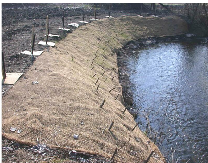
Géotextile + bouturage + plantations
