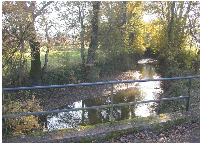
Même pont après entretien - 2005 -
