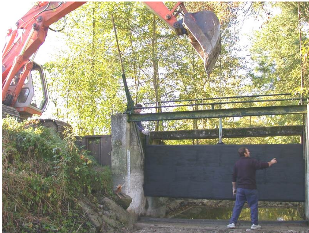
Remplacement de la vanne à clapet du lieu dit « Moulin rouge » Octobre 2003 - Montboyer -
