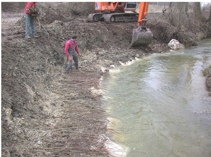
Protection d'un virage à 90° Tude médiane Technique combinée 2 - février 2004 -
