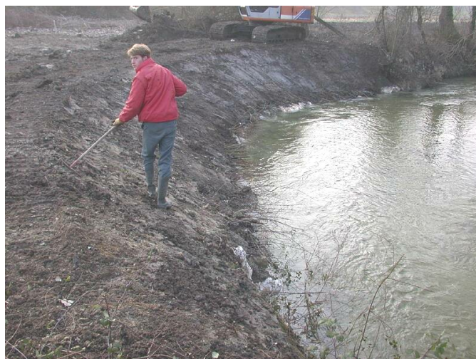
Talutage après pose d'enrochements immergés + installation du lit de plants et plançons de saules + semis de légumineuses et de graminées
