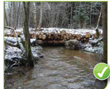
Ponceau en rondins
