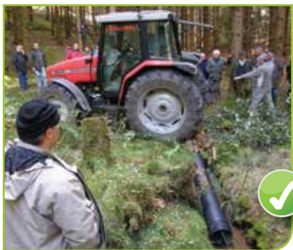
Tube PEHD* recouvert de rondins
