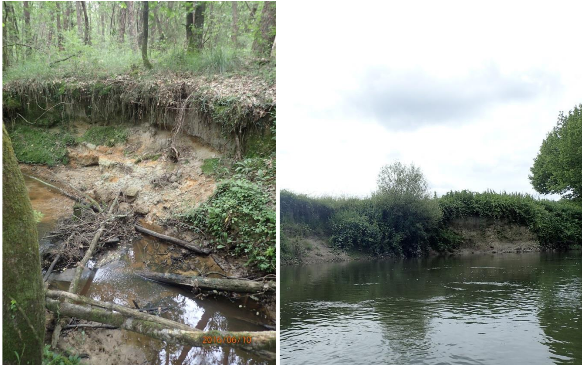
Fig. 27. Anse d'érosion sur le Goulor (à gauche) et sur la Dronne (à droite)
